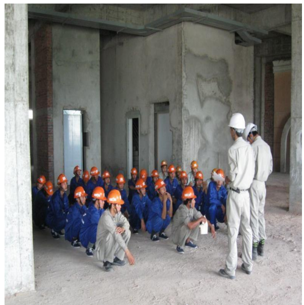
Làm việc tại dự án Sheraton Hotel Working in Sheraton Hotel Project
