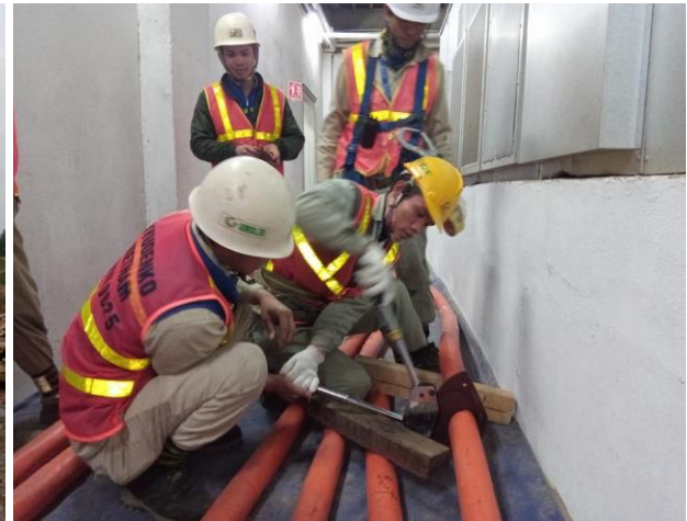
Dự án Meiko 2018 - Cáp ngầm cao áp Meiko Project 2018 - HV Underground
