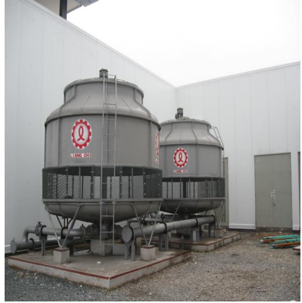
Tháp tản nhiệt Cooling Tower
